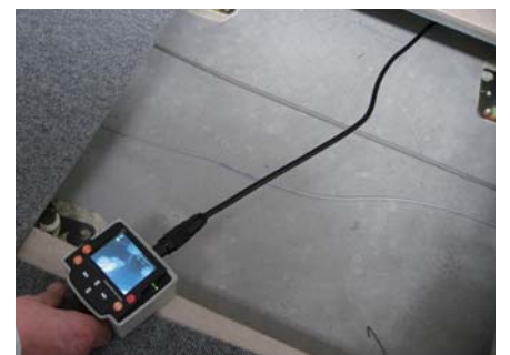
① 床下へカメラヘッド設置
